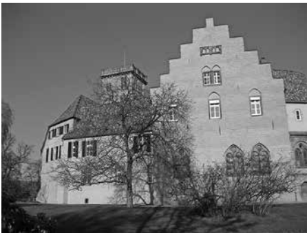
Mit Kalkschlämme fertig gestellte Südfassade mit Rittersaalgiebel
